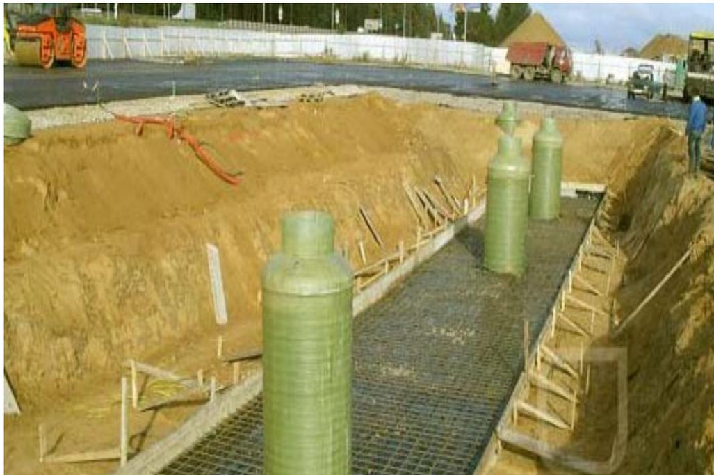
Изготовление распределительной плиты
