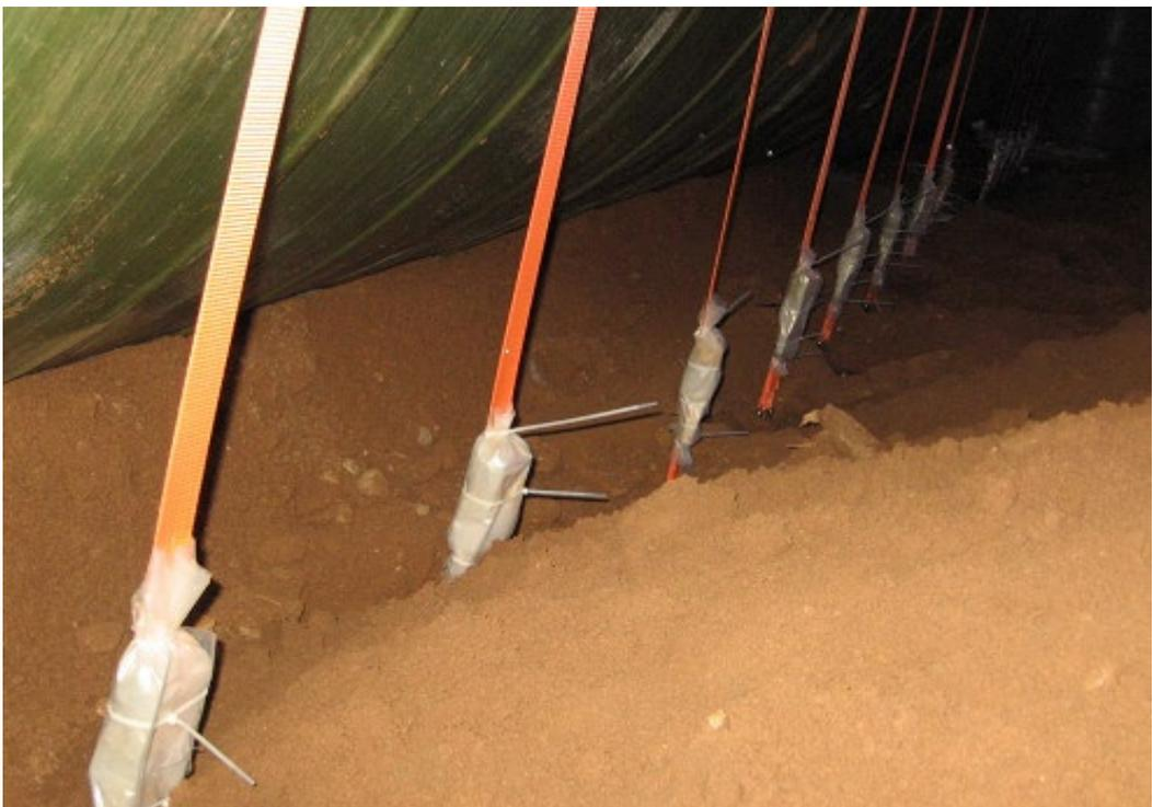
Установка емкости на плите, крепление стяжных ремней
