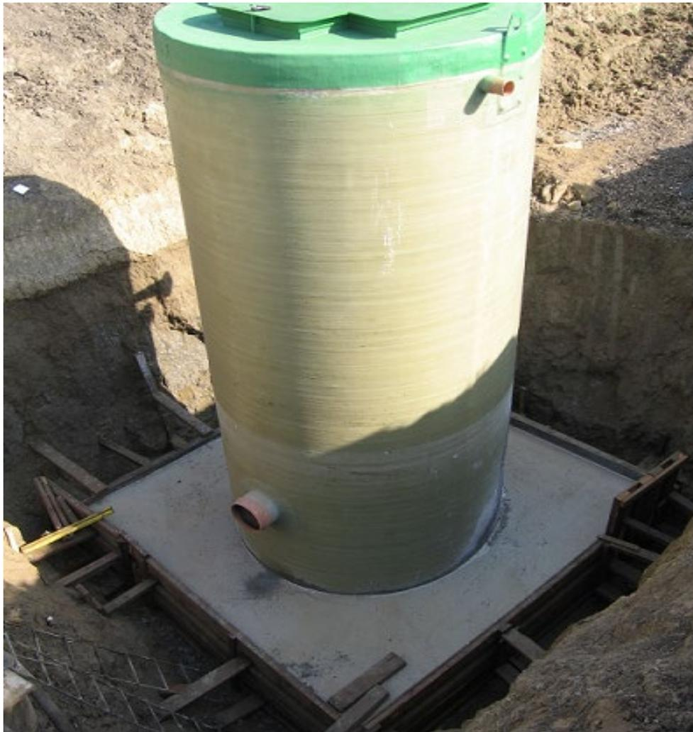
*Установка вертикальной емкости, анкерение и бетонирование.*
